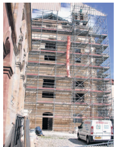
Hinter den Gerüsten ist die zukünftige Fassade schon gut zu erkennen.
